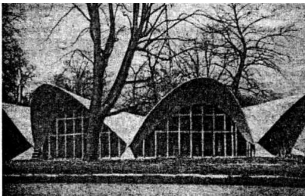
Рисунок 1.11 – Купол-оболочка (зонтичный купол, диаметр 31 м)
