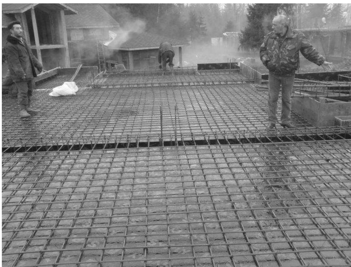
Рисунок 1.3 – Подготовка каркаса монолитного межэтажного перекрытия
