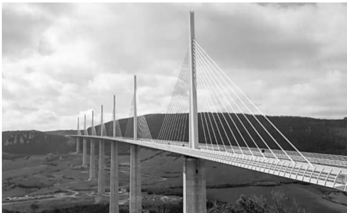
Рисунок 1.20 –Самый высокий мост (виадук) в мире. Длина сооружения 2460 м. Полная высота одной из семи опор 335 м. Южная Франция, Плато Ларзак, г. Мийо, река Тарн
