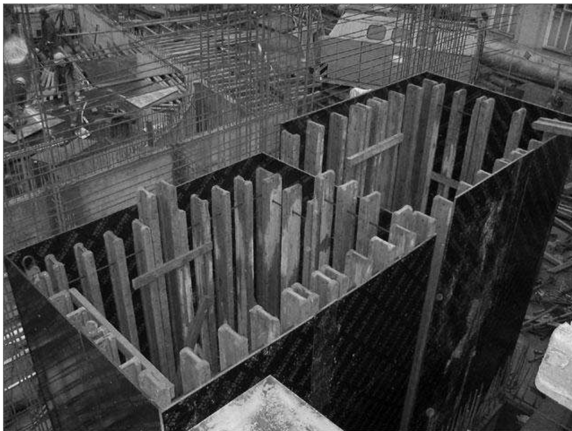
Рисунок 1.2 – Опалубка монолитных стен
